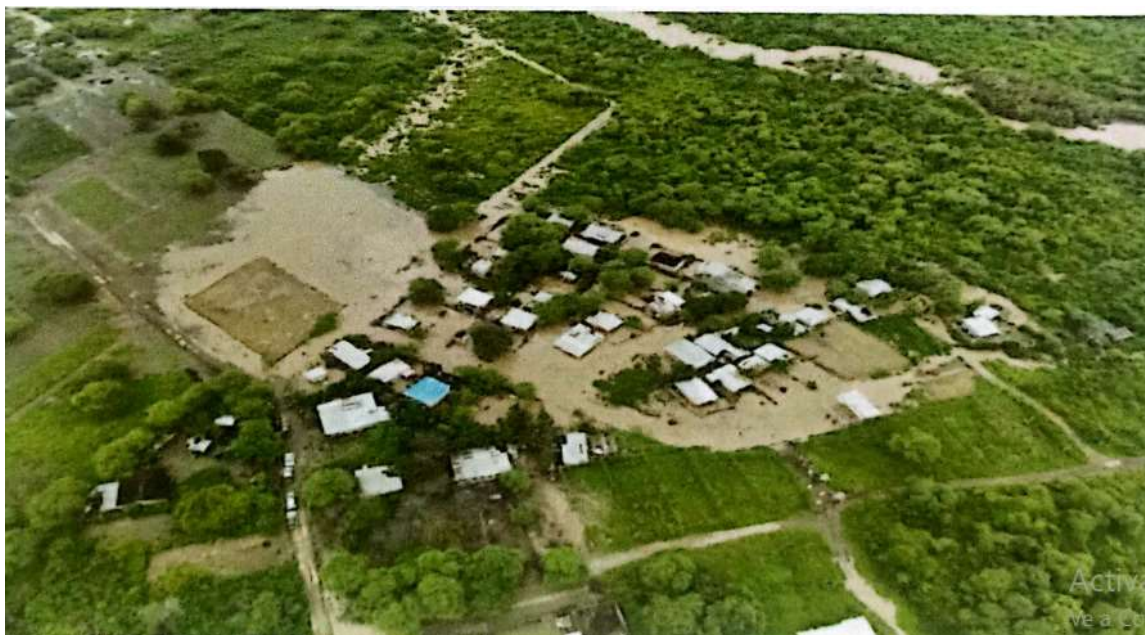
Imagen 19. Asentamiento irregular en la ciudad de Puerto López, sector El Manglar Fuente: Unidad de Riesgo del GAD municipal de Puerto López
