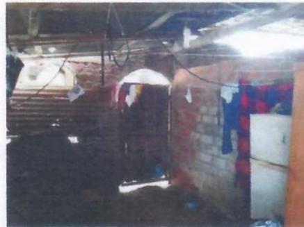
Existe una construcción en mal estado paredes cuarteadas y techo con orificios.
